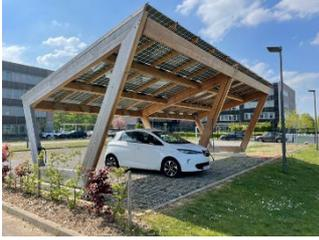
Bien que non soumis à la loi APER, et en conformité avec le programme technique, le projet intègre la réalisation d'ombrières photovoltaïques sur une surface de 120 m<sup>2</sup> de stationnement.
